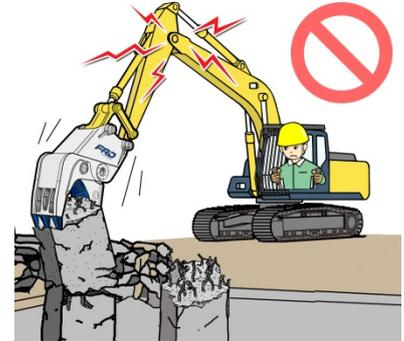
小割圧砕機で基礎解体は行わないこと。噛む力で油圧ショベルや圧砕機の破損事故を引き起こします。
